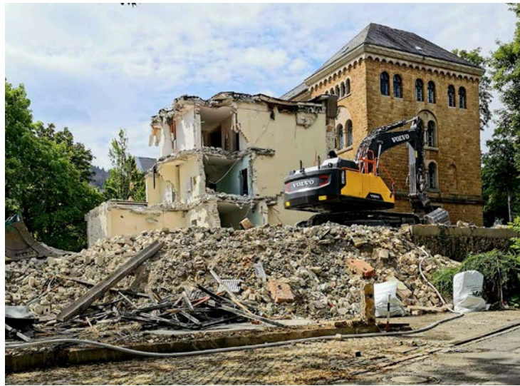
Links: Abbruch der Domkaserne, Anfang 1965, Foto: Photo-sammlung Stadtarchiv Goslar Rechts: Abbruch der BGS-Mannschaftsunterkunft 19. 7. 2023, Foto: privat
