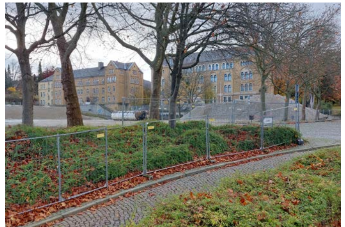
BGS-Kaserne von Nordost am 17. 11. 2023
