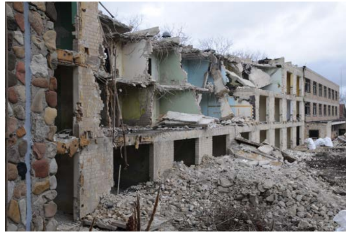
BGS-Kaserne, Fassadenansicht Süd am 5. 3. 2023
