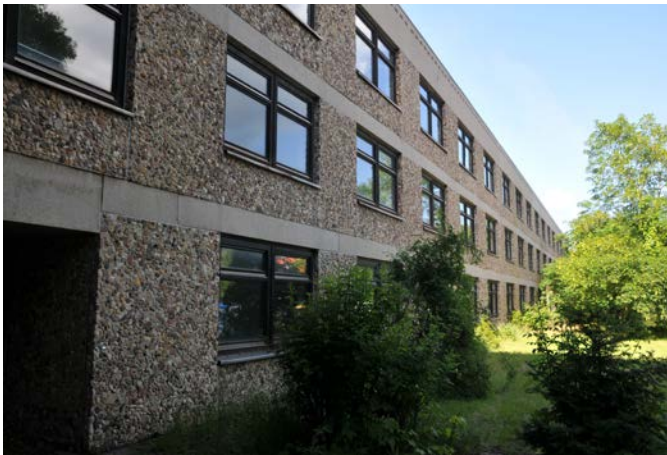
BGS-Kaserne, Fassadenansicht Süd am 30. 5. 2014
