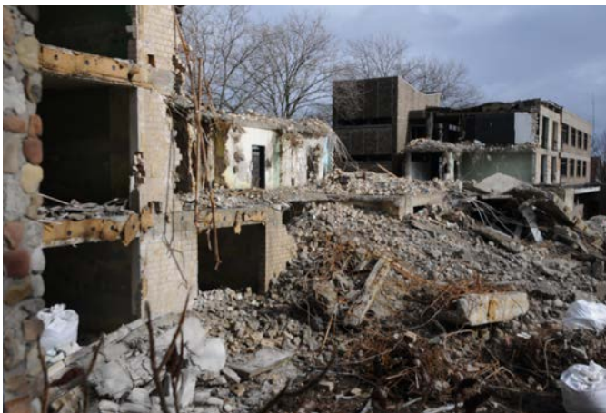
BGS-Kaserne, Fassadenansicht Süd am 13. 3. 2023
