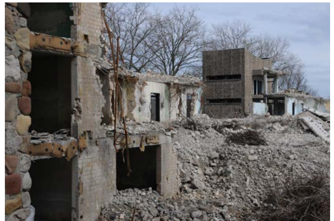
BGS-Kaserne, Fassadenansicht Süd am 19. 3. 2023
