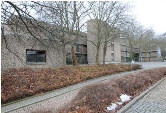
BGS-Kaserne von Nordost am 5. 2. 2023
