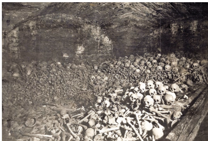
Bis 1907 lagerten 85 Kubikmeter menschliche Knochen unter der Marktkirche. Heute steht an dieser Stelle die Heizungsanlage. Foto: Hans Udolf
