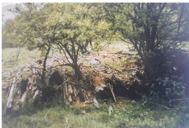
Verwesende Balken der ehemaligen Synagoge unterhalb des Rabenkopfes um ca. 1980. Foto: Hans Manhart
