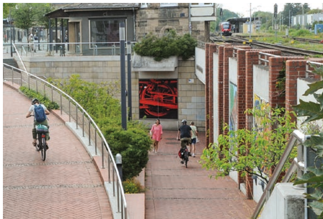
Fußgängerunterführung zwischen Klubgartenstraße, Bismarck- und Tappenstraße mit dem Siebdruck des Rades einer Dampfeisenbahn.
