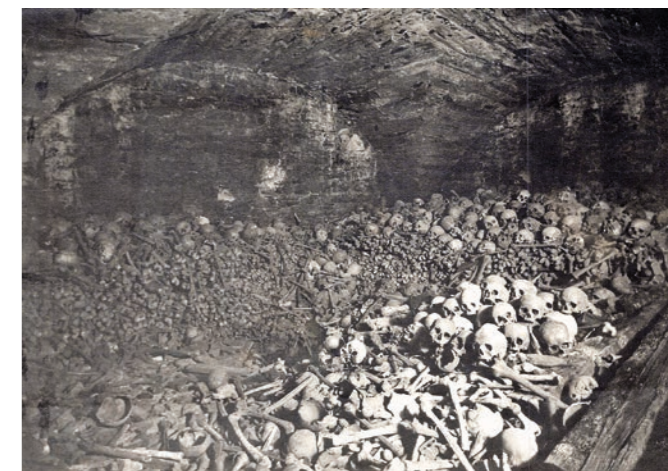
Das ehemalige Beinhaus unter der Marktkirche beweist: Da der Platz auf dem Kirchhof begrenzt war, mussten immer wieder ältere Bestattungen bereits vor der völligen Verwesung der Leichen beseitigt und die Grabstellen neu belegt werden. So sammelten sich 85 Kubikmeter Knochen, die 1907 auf dem Friedhof Hildesheimer Straße beigesetzt wurden. (Foto: Hans Udolf / Repro: HL)
