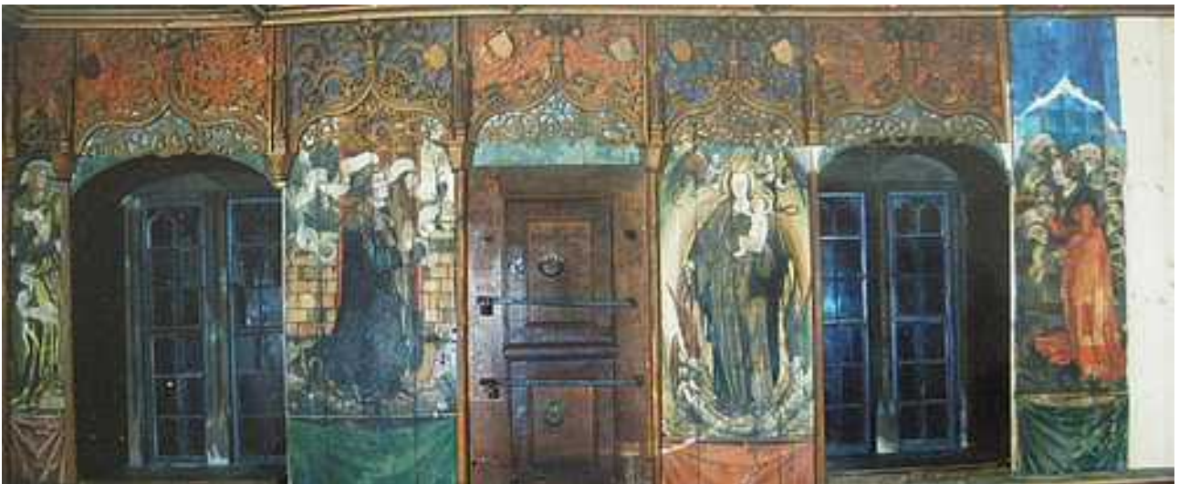
Abb. 1: Westwand des Huldigungssaales während der Restaurierungen in den 1990 Jahren
