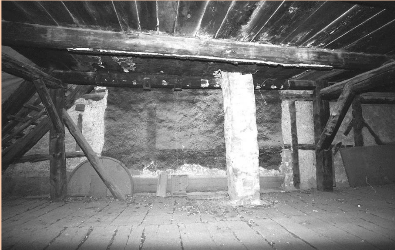
Einbeck, Altendorfer Straße, abgebrochene Räucherkammer vor Brandgiebel im 1. DG, Aufnahme Lucka 1993.
