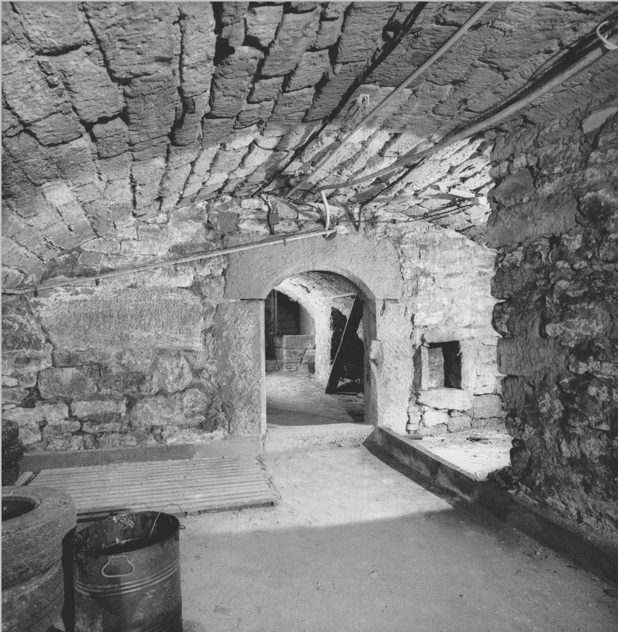
Einbeck, Altendorfer Straße 28, Mitte 16. Jh., mehrteilige Kellieranlage unter Vorderhaus und Seitenflügel aus dem 15. und 16. Jh., Aufnahme Brüdern 2015, aus: Kellmann, Bd.7.4, 2018, S.47.
