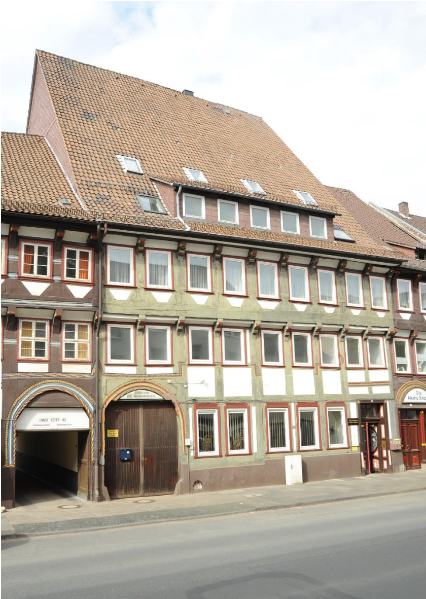
Einbeck, Hullerser Straße 16, achtgeschossige Braudielenhäuser, um 1565, Aufnahme Kellmann 2018, aus: Kellmann, Bd.7.4, S.343.
