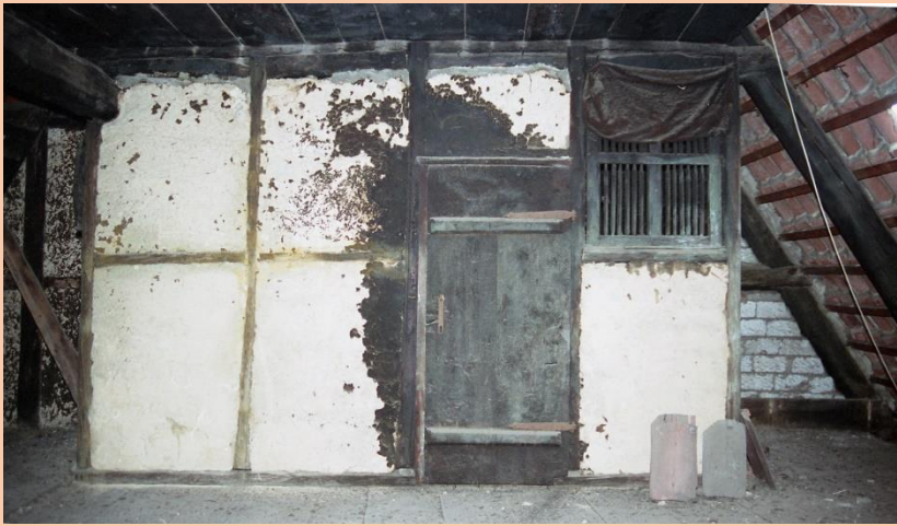
Einbeck, Marktplatz 31, von 1551 mit Räucherkammer vor Brandgiebel im 1. DG, Aufnahme Kellmann 2002
