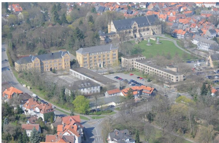
Krahrner-Möllenberg-Kaserne (links), Kaiserbleek-Kaserne (Mitte) und davor ehemalige Gebäude des Bundesgrenzschutzes (Foto: Günter Piegsa)
