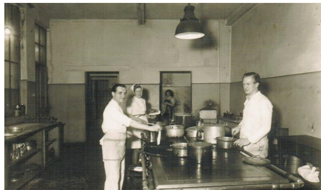
Donato (links) in der Küche der „officers mess“, des Offizierscasinos des Fliegerhorstes. Die Küche wurde 1990 umgebaut. Das Casino wurde 2018, obwohl als Einzeldenkmal unter Schutz gestellt, von der Klosterkammer Hannover abgebrochen.
