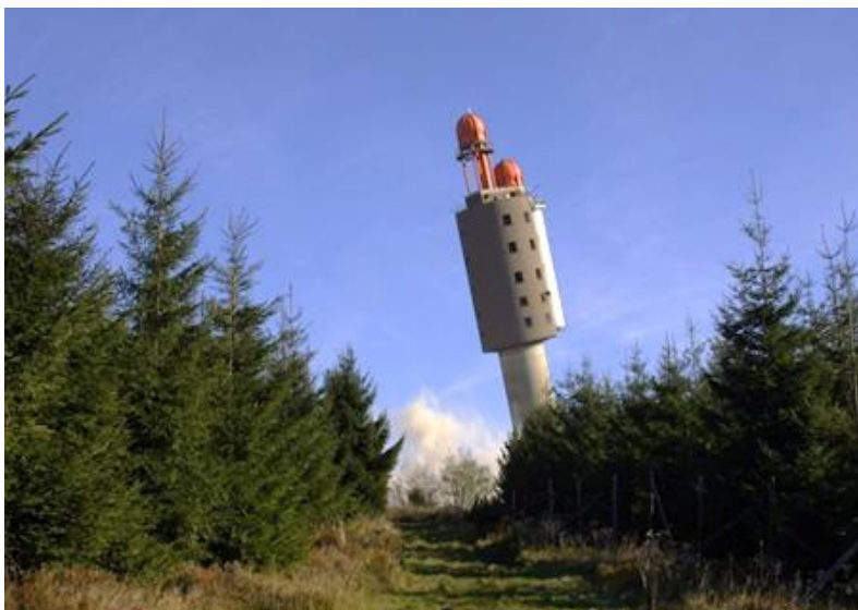
Sprengung Schalker Turm, am 11.10.2002 13:00 h (Foto: Martin Schenk)
